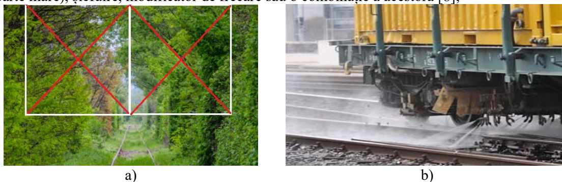
Fig. 5. Fotografie cu: a) gestionarea vegetației; b) sablarea șinelor cu apă la presiune foarte mare.
