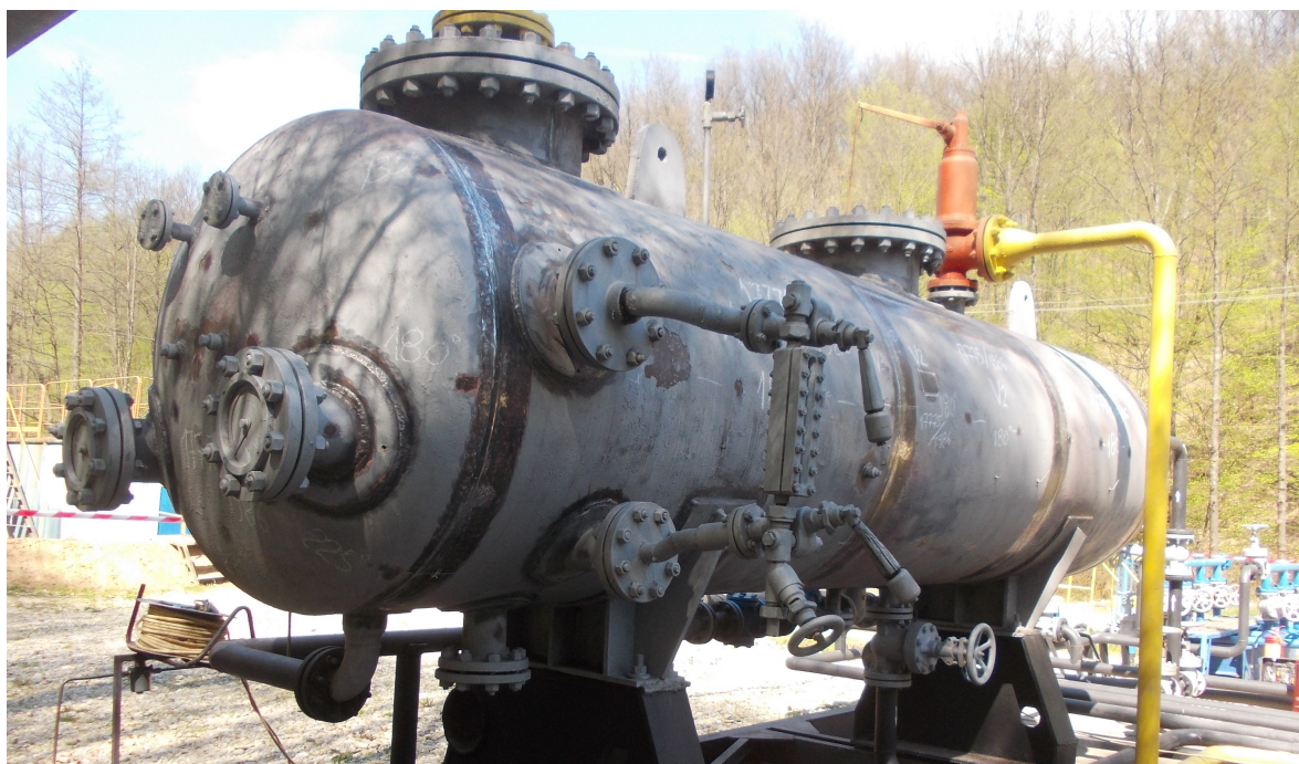
Fig. 2.1.5 – Recipient pregătit pentru examinări NDT (încercare nedistructivă).
