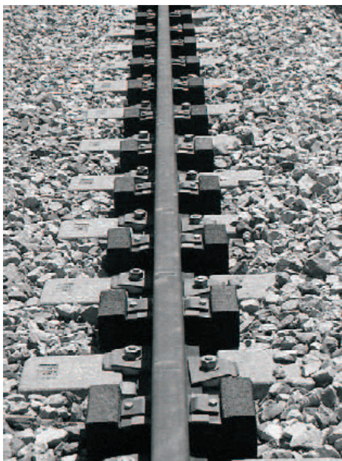
Fig. 1. Amortizare dinamică a vibrațiilor fixată pe o șină pentru reducerea poluării fonice.
