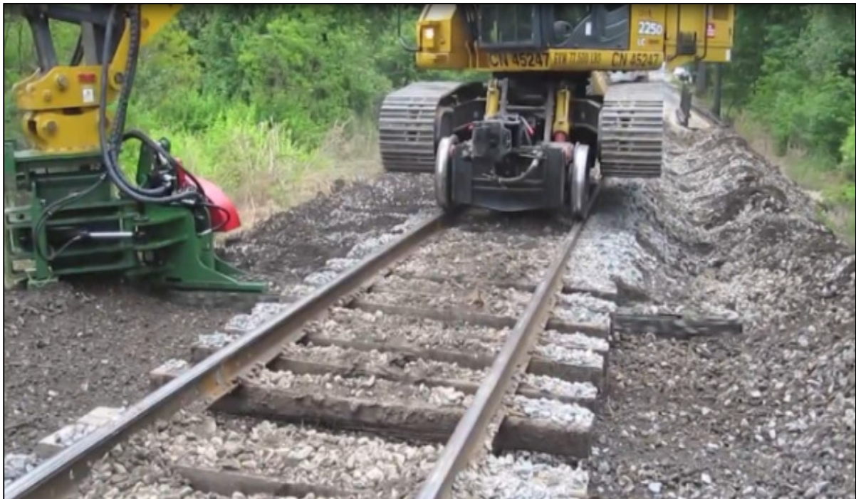
Fig. 5. Excavator prevăzut cu sisteme de deplasare “drum-cale”
