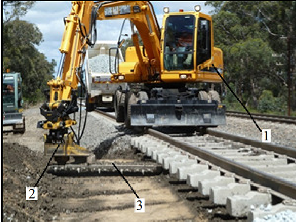
Fig.2 Mașină de bază (excavator) prevăzută cu echipament de lucru tip lanț port-dinți 1 - excavator; 2 - corpul echipamentului; 3 - cadru (brat) de excavare cu lanț port-dinți
