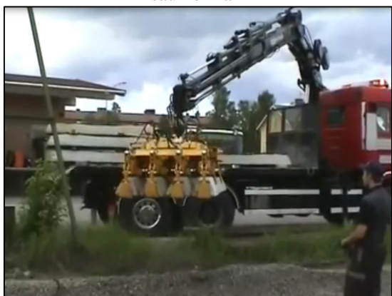
c. macara hidraulică cu braț articulat montată pe șasiu auto, care poate lucra în zona adiacentă liniei
