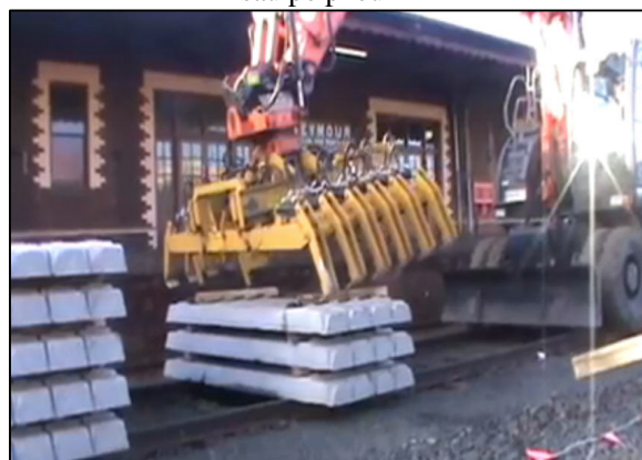
d. excavator cu sistem de deplasare drum-cale
