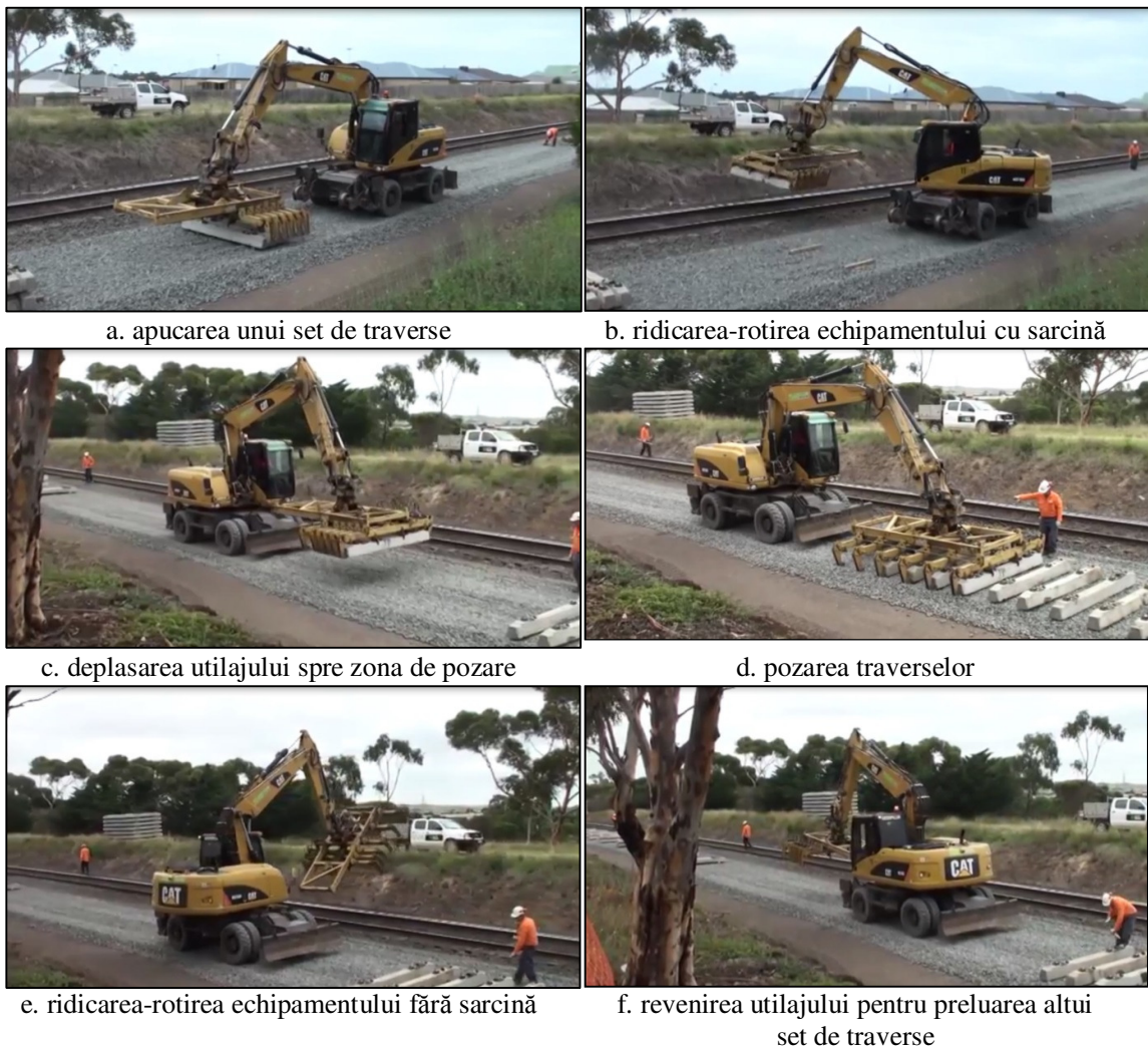
Fig.6 Pozarea traverselor preluate din depozite provizorii formate în axa căii
